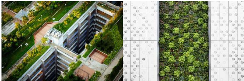
4. ábra Intenzív, rekreációs célú zöldtető (balra) és zöldhomlokzati megoldás (jobbra)(képek forrása: unsplash)
