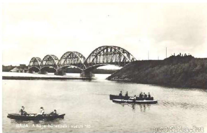
7. ábra A fővonalai 598 méteres bajai híd (1906–1911)
