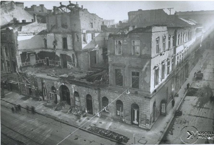
3. kép A rommá lőtt épület 29
